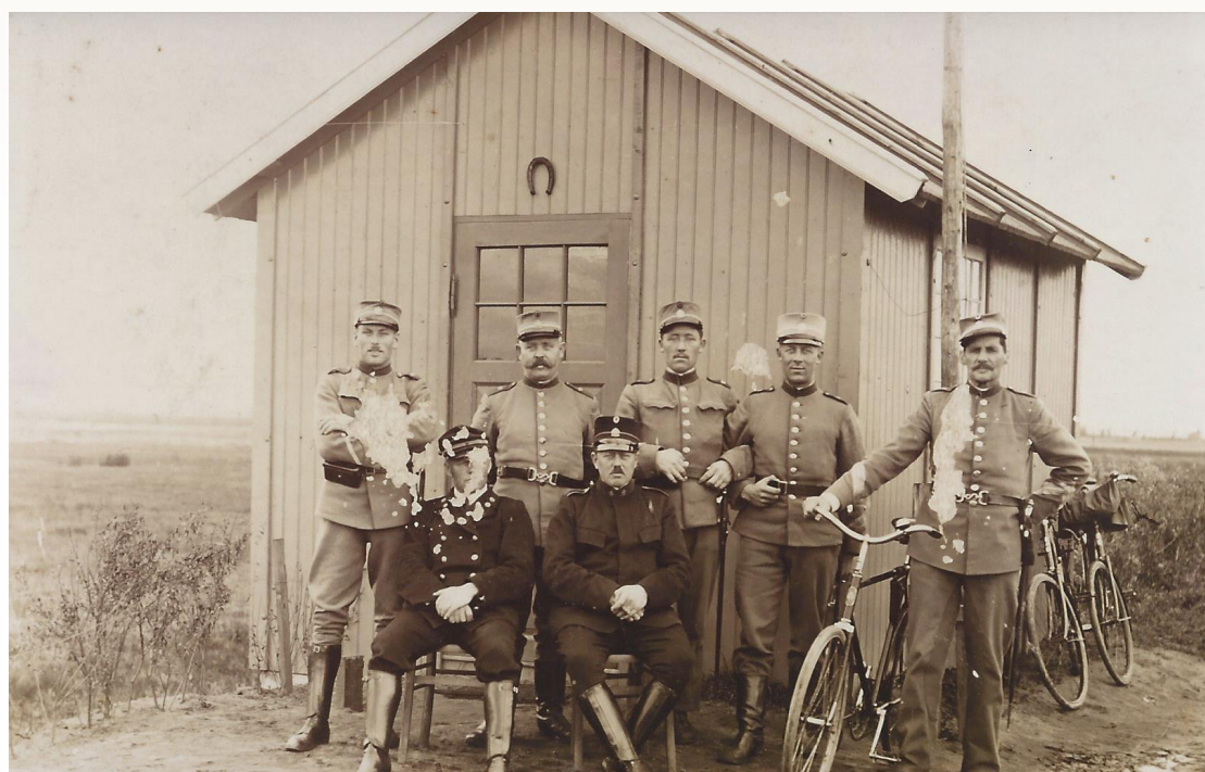
Den første grænsebygning ved Sæd 1920.
