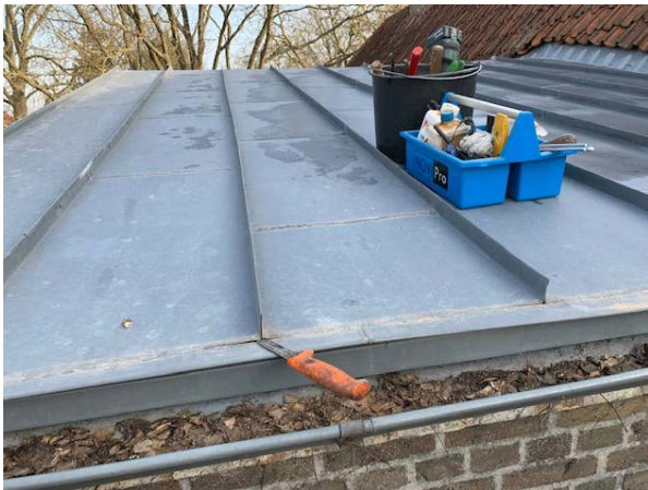
Besigtigelse af frontispicens tag, viser tydelige tegn på tagarbejde som ikke er udført håndværksmæssigt korrekt.
