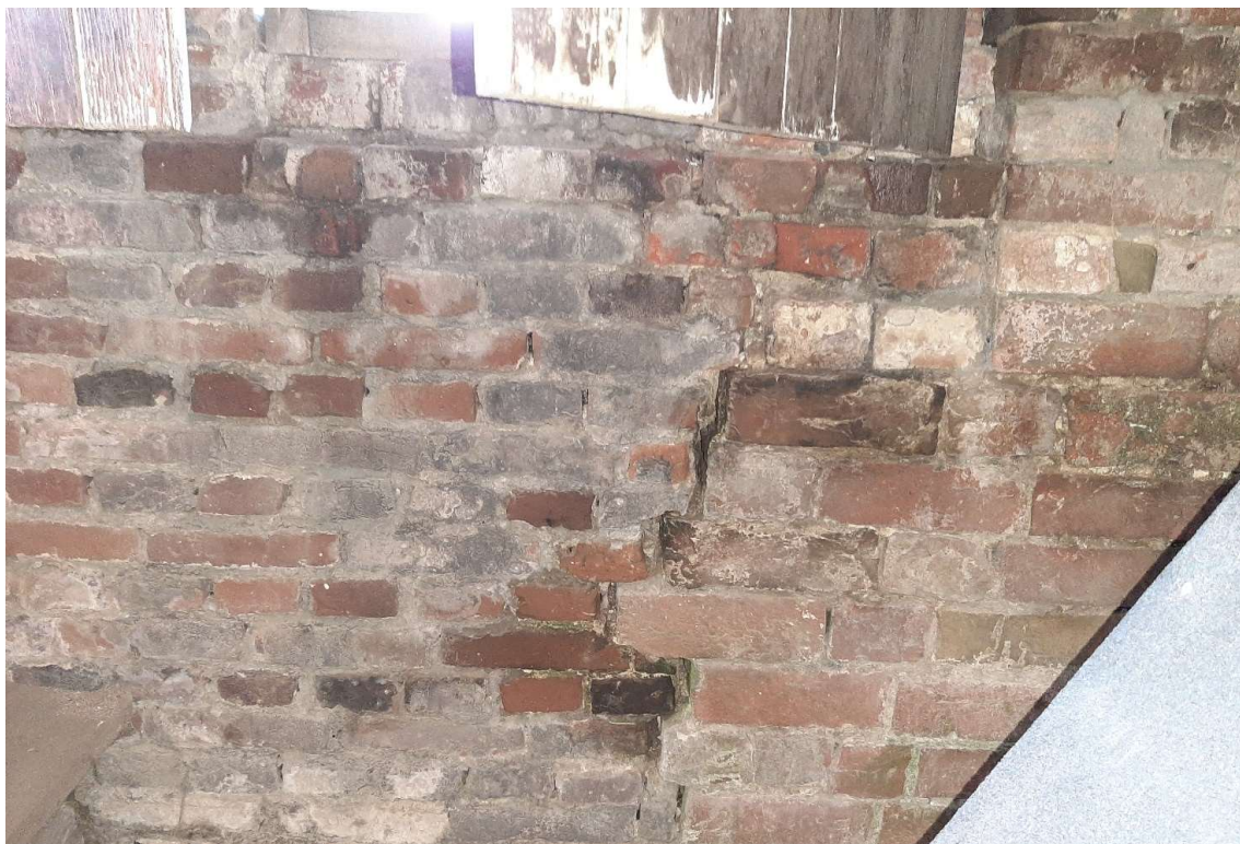
Murværket ved klokkelugen set indefra.
