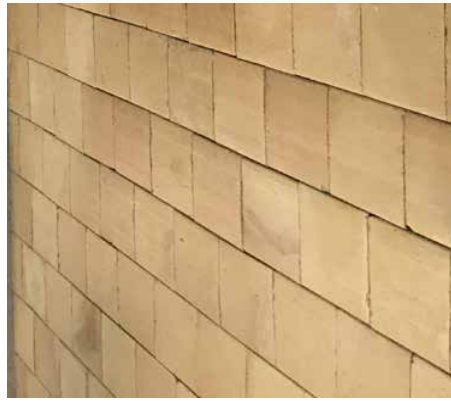
Gentagelse af eksisterende teglbelægning i tilbygning og kor
