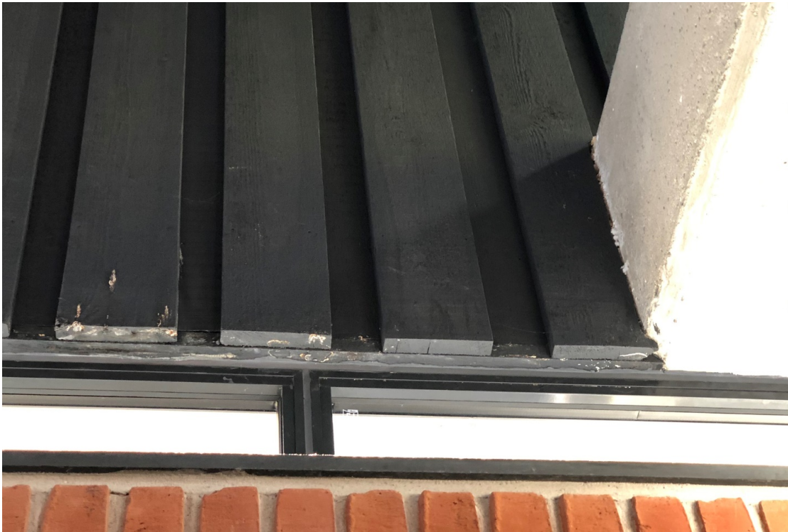
Svampe, nederst i træbeklædningen. Dette kan være en anden type end de store frugtlegerer.
