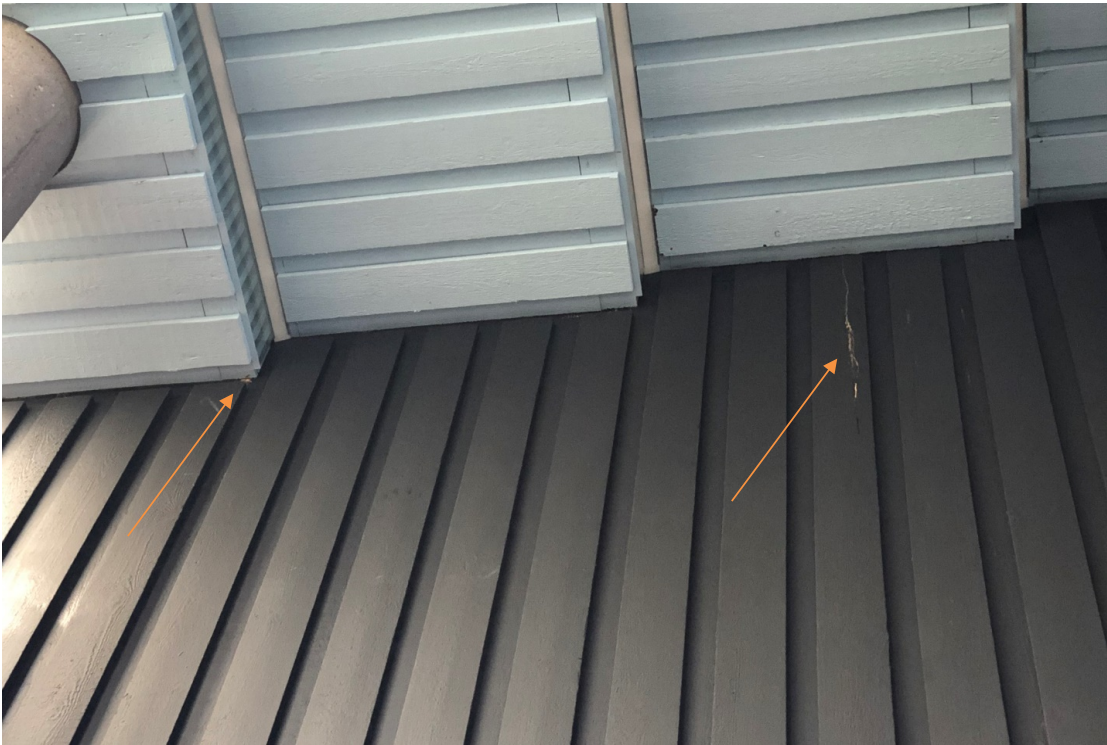
Ydervæg og loft mod syd. Bemærk svampe frugtlegemer ved pile.
