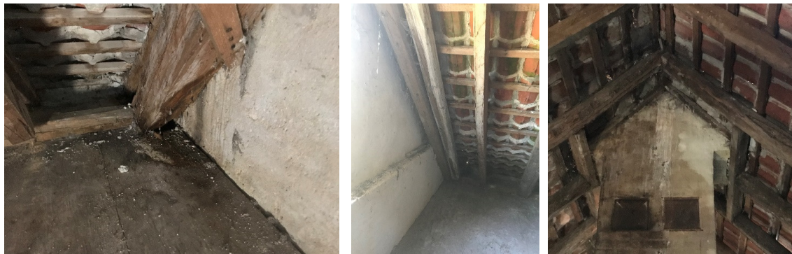
Fig 6 Eksempler på skader i tagtømmer
