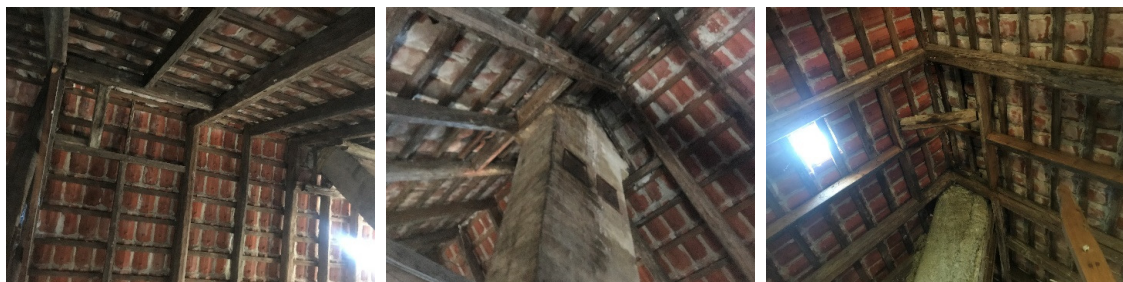
Fig. 10 Udvekslingerne i tagkonstruktionen. Skorstenspipe A, B og C set fra venstre
