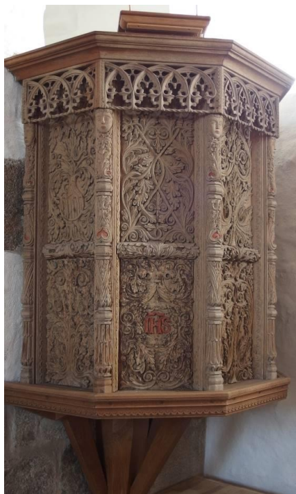
Prædikestol fra ca. 1575. Foto th.: Udskæringsarbejdet er skæmmet af en opfyldningsmasse med en afvigende, mørkebrun farve.
