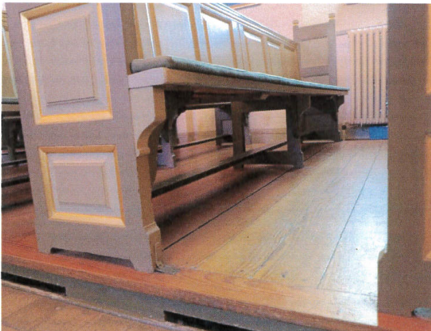
Bænke monteret med metalbeslag.
