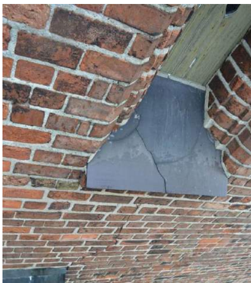
Fig 23: Eksempel på revnet skiferplade
