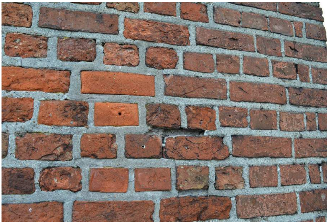
Fig 18: Eksempel på tårnets murværk med renæssanceforbandt og cementfuger
