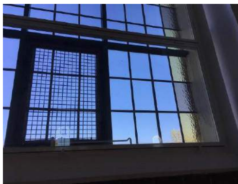
Fig 30: Detalje forsatsramme
