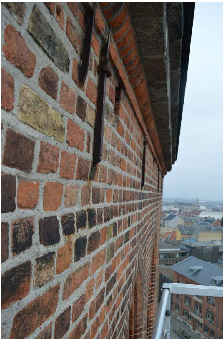
Fig 17: Trykket murværk nordfacade
