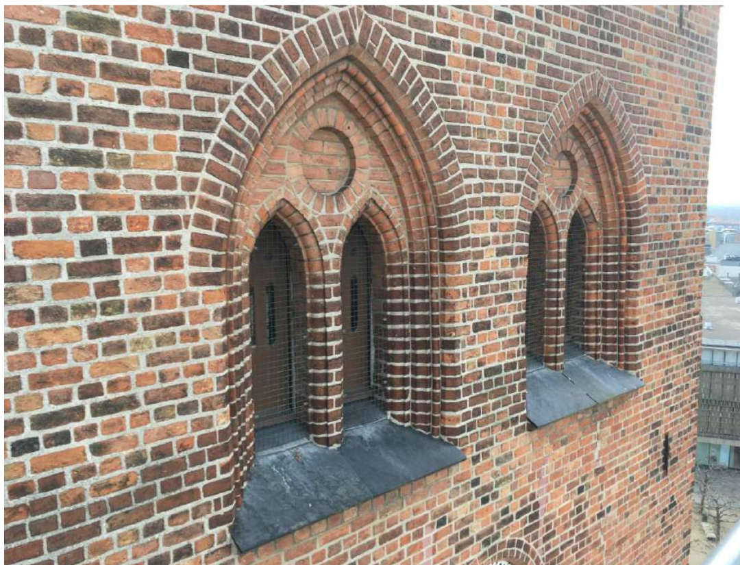
Fig 22: Dobbelte muråbninger med skifersålbæmke
