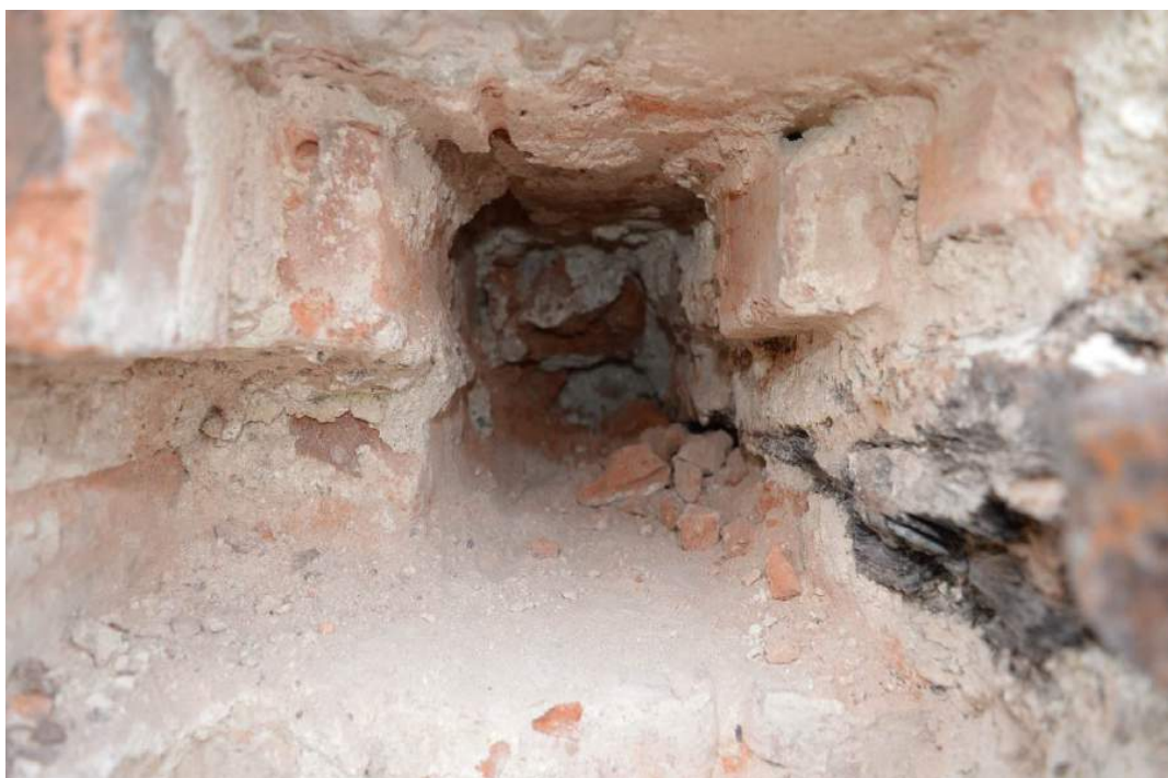
Fig 5-7: Eksempler på prøveudhugninger og ankre under murkrone
