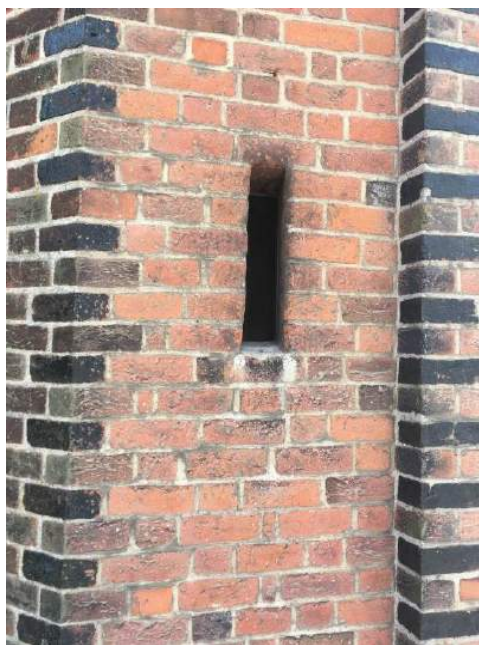
Fig 24: Eksempel på glughul – gitter mangler
