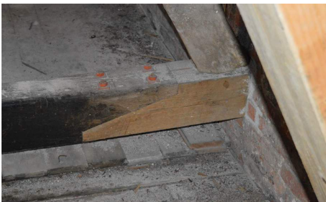
Fig 11-13: Indvendige stag, fliganker og træsamling i bjælke
