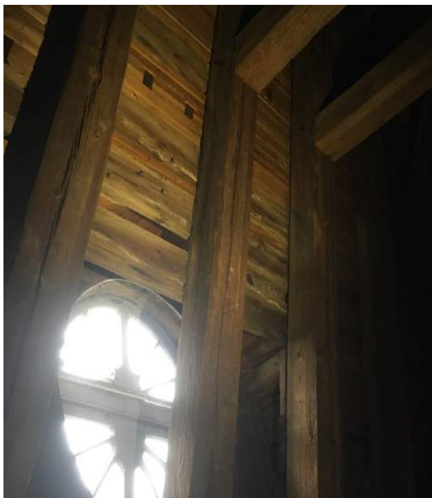
Fig 27: Opfugtede undertagsbrædder
