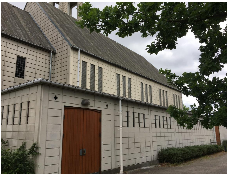
Foto 1. Oversigtsfoto. Facade mod nord.
