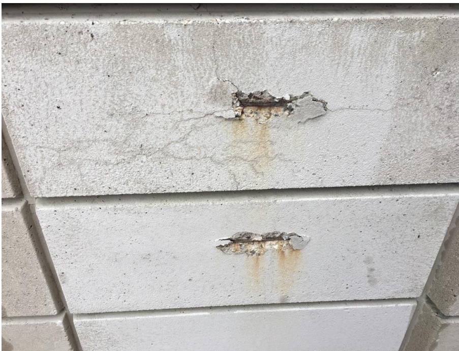
Foto 11. 2 blokke med afskalninger. På den øvre blok ses desuden flere revner.
