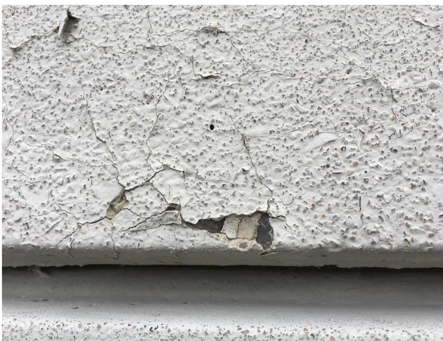
Foto 15. Nærfoto af krakeleringer og afskalninger af overfladen.
