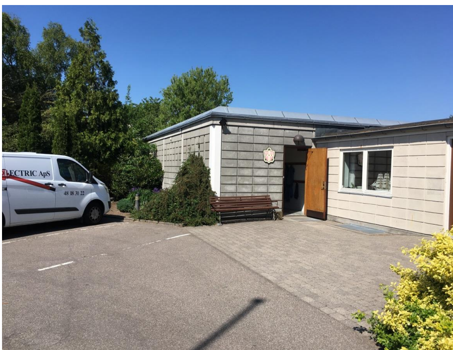
Foto 3. Oversigtsfoto. Tilbygning/konfirmandstue og mellembbygning.
