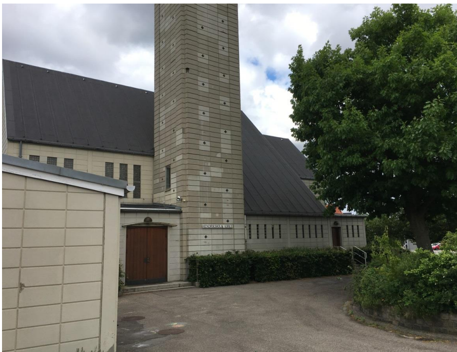
Foto 2. Oversigtsfoto. Facade mod syd.
