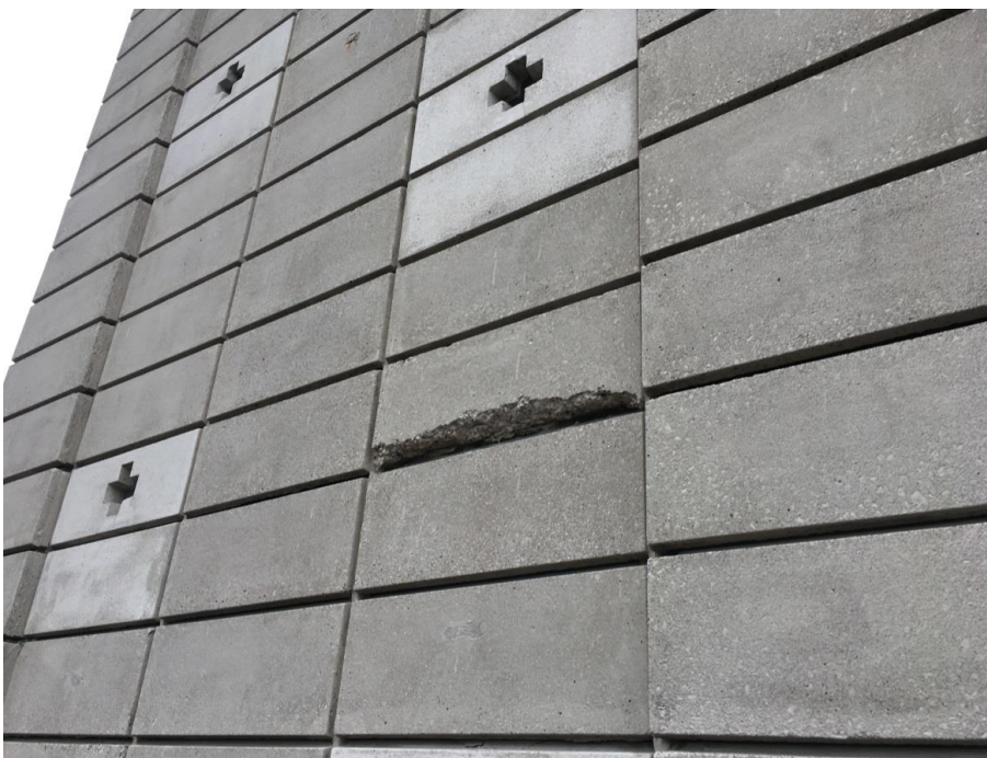
Foto 13. Blok med afskalning af den nederste del af blokken.
