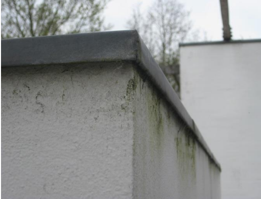
Foto 11 – udhæng på eksisterende læmure (10-12 mm).
