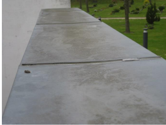
Foto 12 – overside på læmure uden fald.
