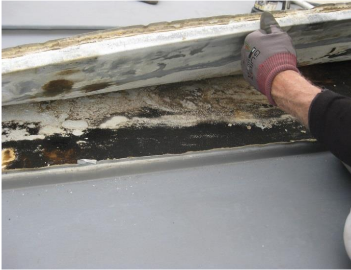
Foto 8 – åbning nr. 1. (hvidrust under zinkplade)
