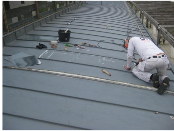
Foto 2 - forberedelse inden pålodning af zinkplade.
