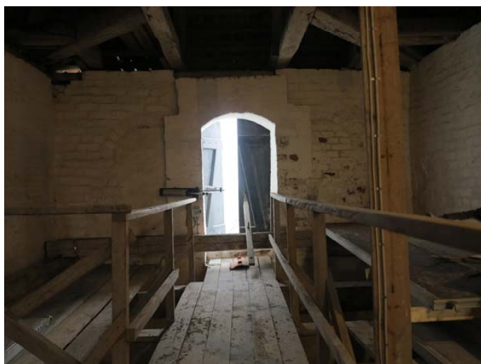
4. stokværk med gangbro til glamluge mod nord
