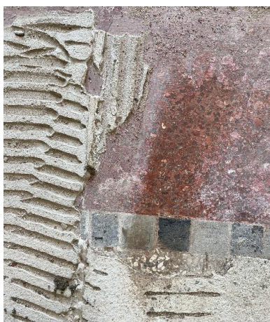
Ved renoveringen fandt man det gamle terrazzogulv under klinkerne.
