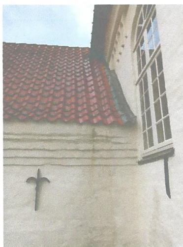
Tag uden tagrende med fugt på ydervæg
