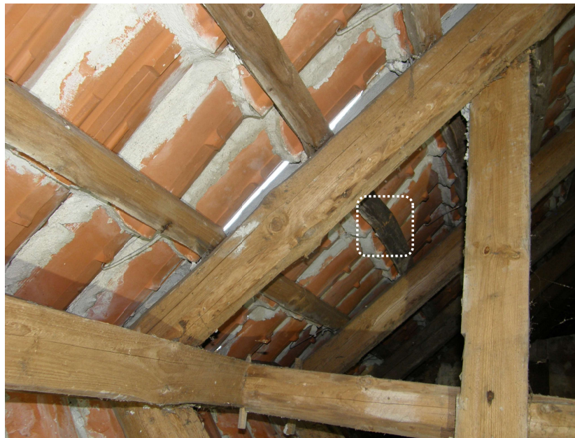
Billeder her viser bl.a. knækkede lægter og et sted ved rygningen, hvor der tilsyneladende er utæthed. Skotrenden er ofte også en svaghed, når den har en alder, som de nu har.
