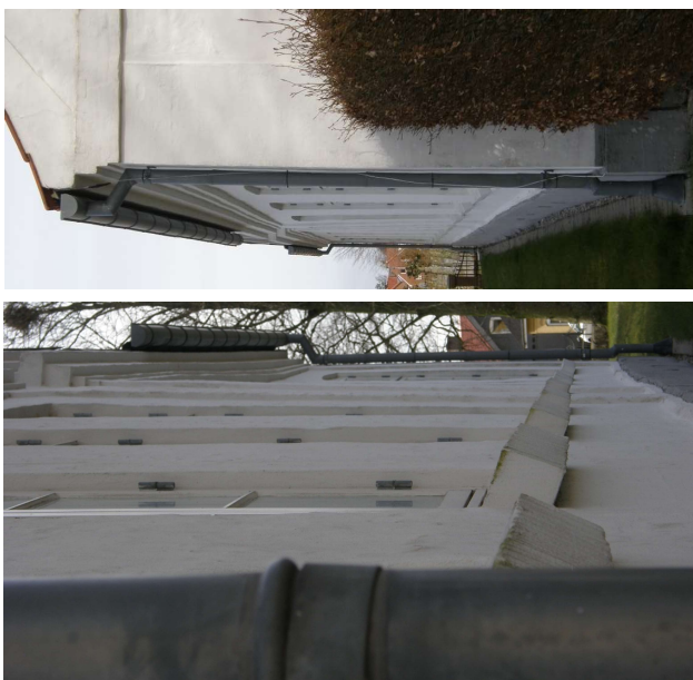
På facaden mod gaden ses at muren/gesimsen ved området omkring den tidligere frontkvist bliver trykket udad.
