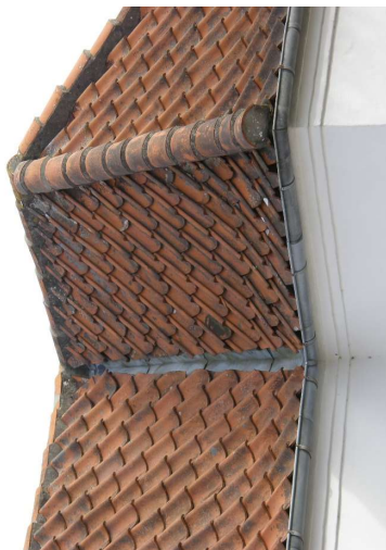
Billeder her viser bl.a. knækkede lægter og et sted ved rygningen, hvor der tilsyneladende er utæthed. Skotrenden er ofte også en svaghed, når den har en alder, som de nu har.
