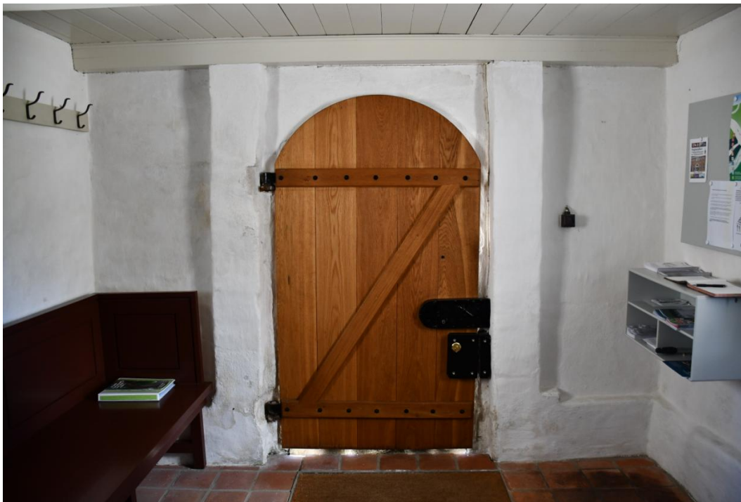
Udgangsdør i koret
