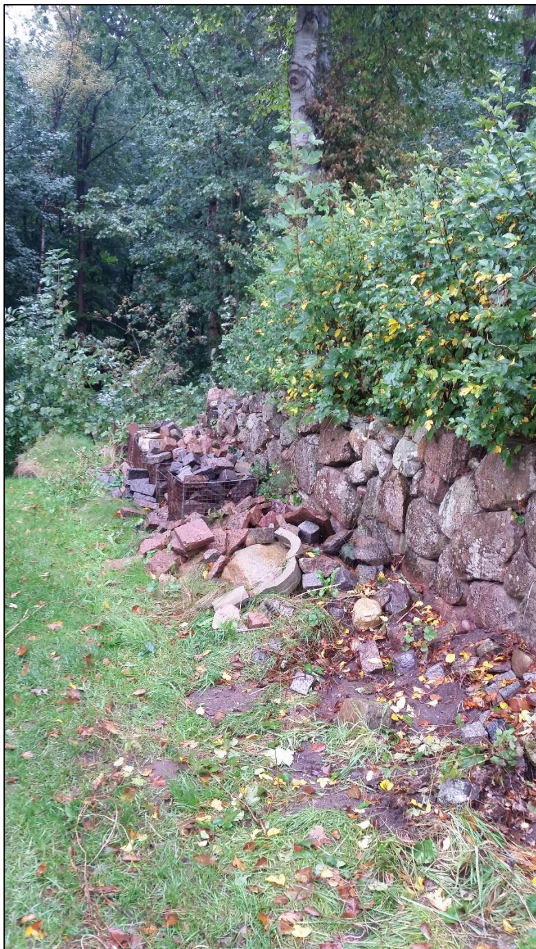
Foto nr. 4 – Fotoet viser sten der skal fjernes.
