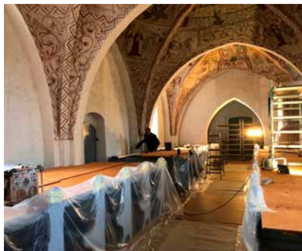
Mørkøv Kirke får kalket væggene, der var blevet sodet med årene. Den lysere kirke er klar igen til marts.
