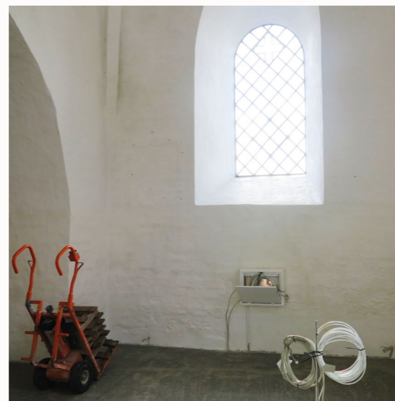
NYT, STØBT BETONGULV
