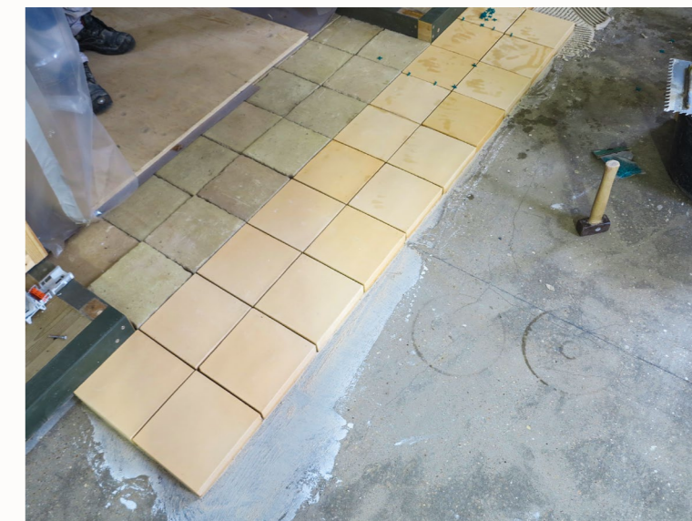
NYE TEGL LÆGGES PÅ
