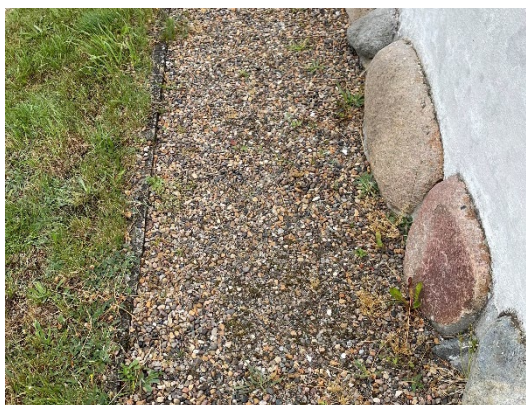
Figur 2. Terræn omkring kirken med cementkant. Figur 3. Sokkelsten med cement ”fuger”.
