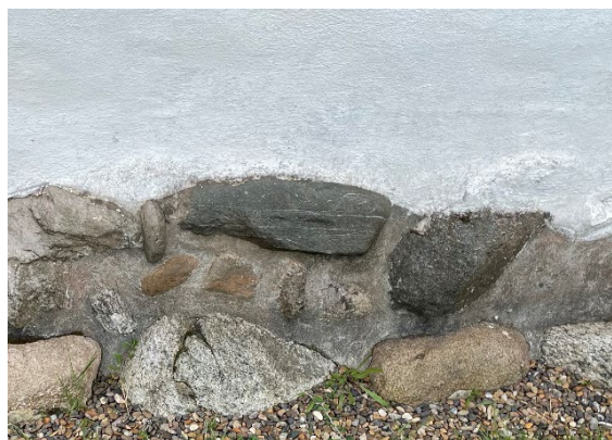
Figur 2. Terræn omkring kirken med cementkant. Figur 3. Sokkelsten med cement ”fuger”.
