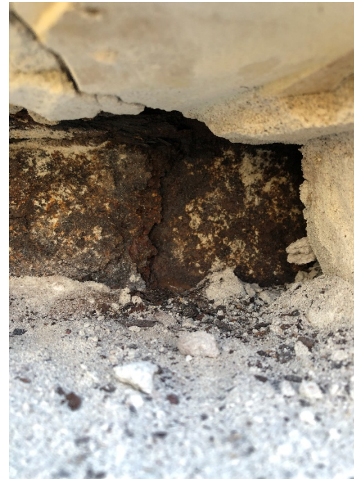
Indvendigt konstatering er stålbjælke over vinduer, som korrigeres grundet alder og fugt, og som trykker murværket ud.
