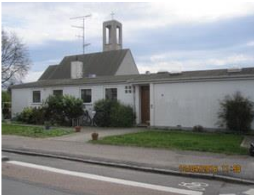
Foto 1. Skodborgvej 1, 2610 Rødovre (facade)
