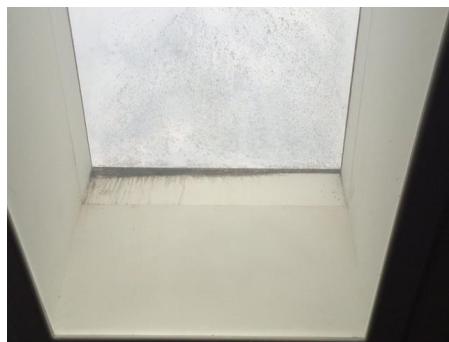
Foto 5. Lysskakt i arbejdsværelse
